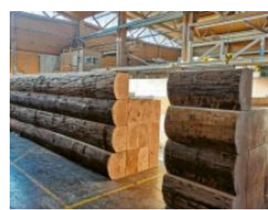
Bei der Binswanger Firma Gump & Maier GmbH entsteht unter anderem die neue Wegkapelle für Unterliezheim.
